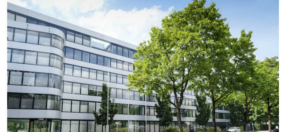
Büro · Landsberger Str. 284–288, München · Green Building
